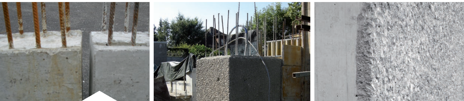
Konventioneller Betonstahl (links) und Top12 (rechts)
