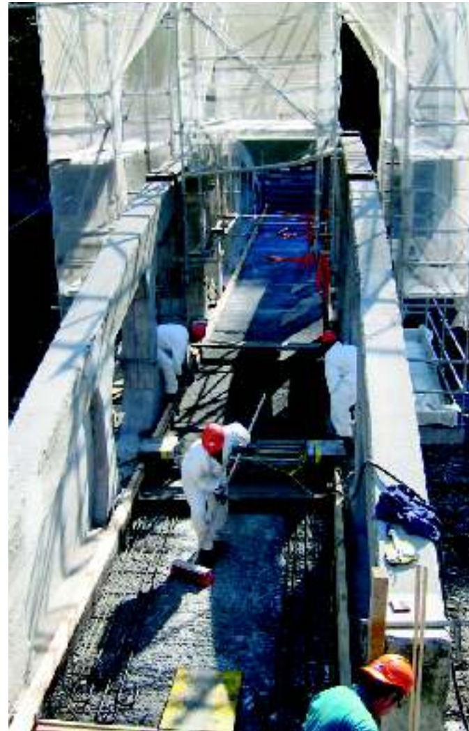
Verwendung von Stahl-UHFB bei der Verstärkung einer Rippendecke im Feuerwehrgebäude in Genf sowie bei der Instandsetzung der Dalvazzabrücke in Luzein GR (rechts).
