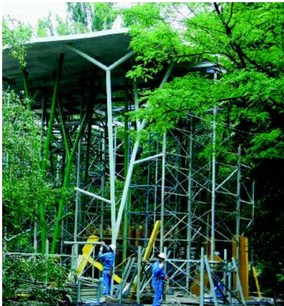
Für die Bewehrung der schlanken Betonplatte der Voliere im «Bois de la Bâtie» in Genf wurde ein nicht rostender Stahl eingesetzt.
