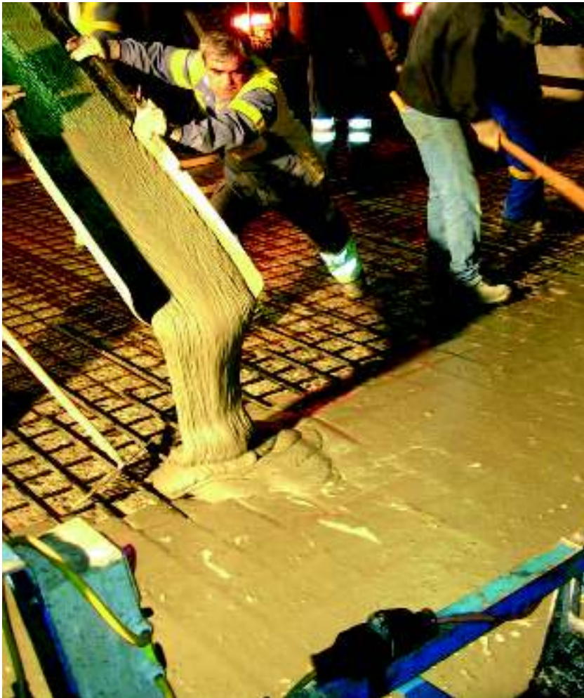
Verwendung von Stahl-UHFB bei der Verstärkung einer Rippendecke im Feuerwehrgebäude in Genf sowie bei der Instandsetzung der Dalvazzabrücke in Luzein GR (rechts).
