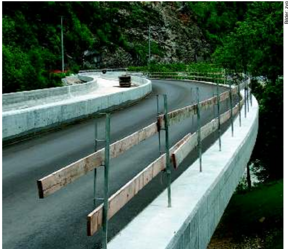
Für die Bereiche im Spritzwasser der neuen Brücke über die Vispa bei Kalpetran VS wurde eine nicht rostende Bewehrung verwendet.
