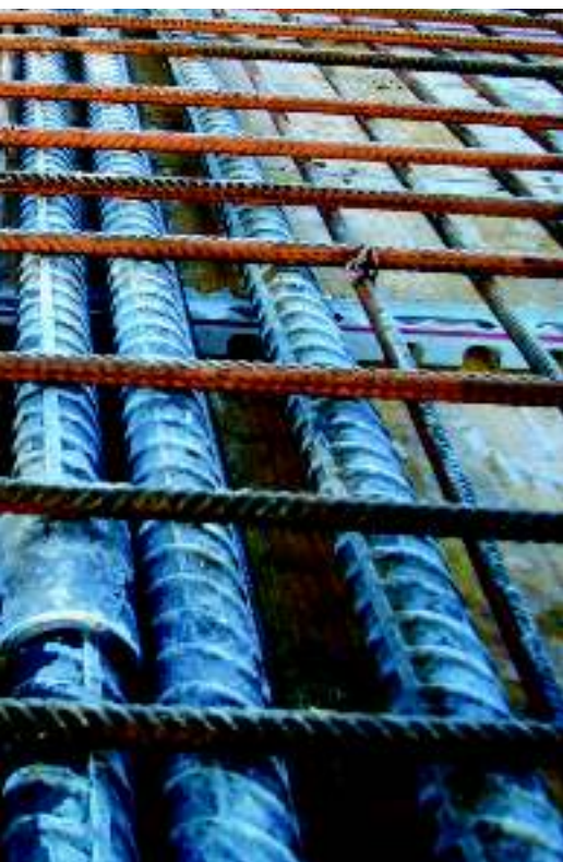
Die Verwendung von höher festem Betonstahl in einer weitgespannten Decke.
