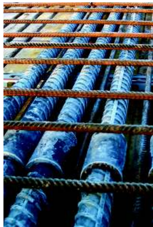
Für die Bewehrung der schlanken Betonplatte der Voliere im «Bois de la Bâtie» in Genf wurde ein nicht rostender Stahl eingesetzt.
