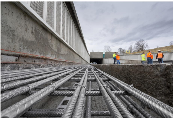
Bild 2: Einsatz von Top12 (1.4003) mit erhöhtem Korrosionswiderstand für Notgehwege
