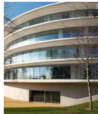
UEFA à Nyon – Un nouveau bâtiment MINERGIE-ECO aux dalles allégées par le système COBIAx et aux besoins en ventilation réduits par les avant-toits, fixés par des liaisons d'armatures BARTEC.
