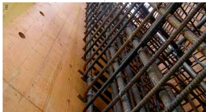
Pont sur le Rhône aux Evouettes. L'acier à haute limite élastique TOP700 permet de réduire la densité d'armature des piles fortement sollicitées.
