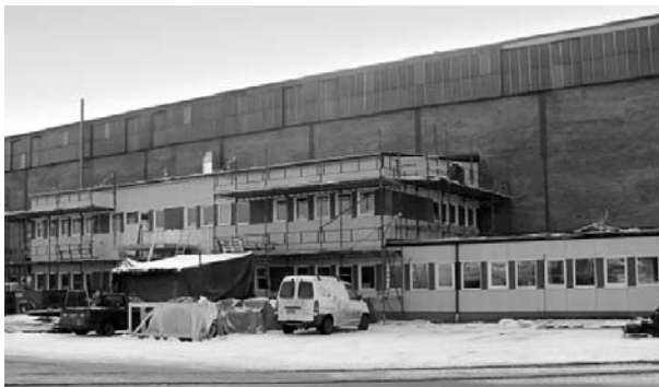
Boxholm: Neues Bürogebäude im Bau
